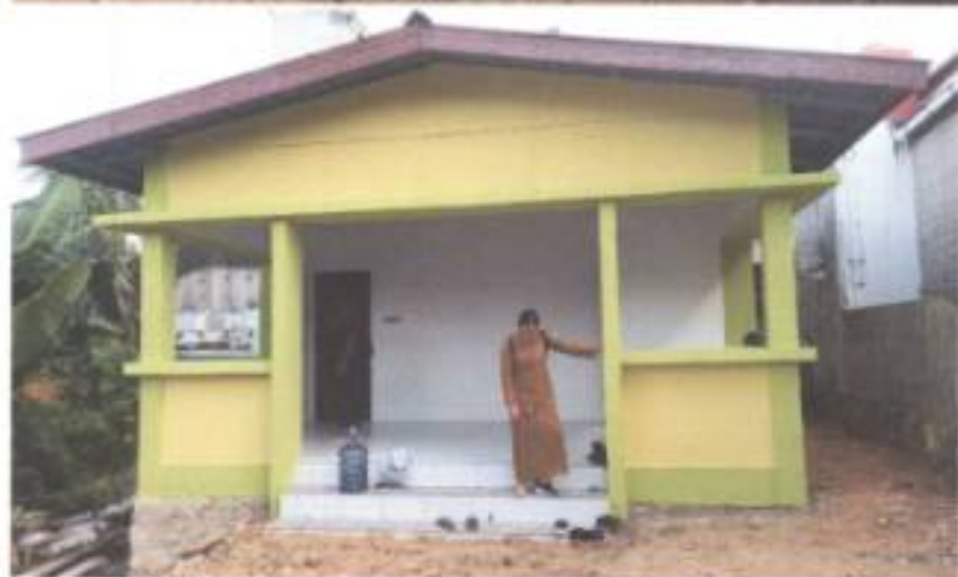
• Pembangunan BPU RT.41
